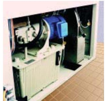
*Ein automatisch arbeitendes Bandfilter sorgt stets für einen sauberen Kühlkreislauf.*
